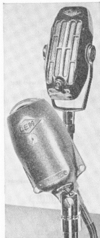
fig. 17. Bovenste afbeelding: bandmicrofoon; onder: dynamische microfoon
